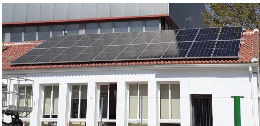
Imagen 4: Organigrama del proyecto SENDA SCHOOL y ejemplo de instalación en un centro educativo Fuente: oteagranada.com
